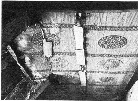
Abb. 6. Zürich, Fraumünsteramtshaus, Dachraum mit den gleichen Medaillons wie im Haus Weite Gasse 11; abgebrochen 1898
