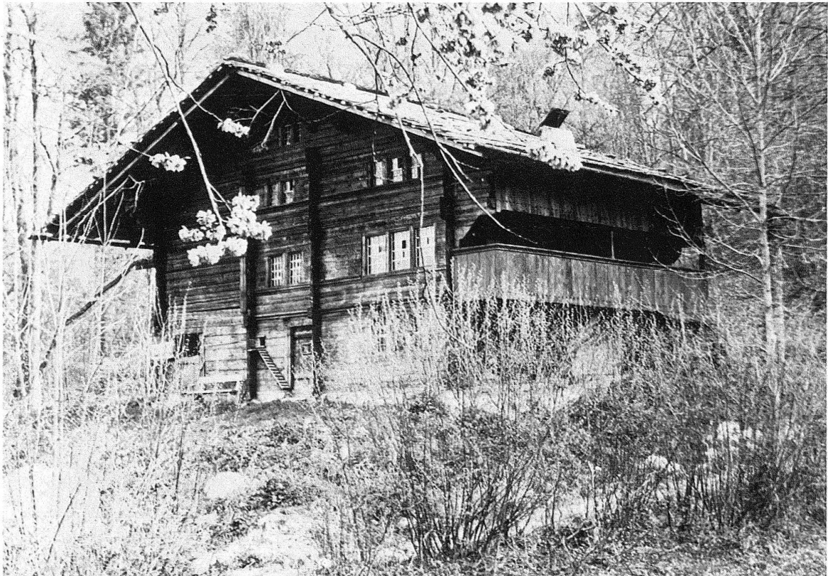
Freilichtmuseum Ballenberg. Das Adelbodner Haus, in der «Kammer» Berner Oberland. – Ein neuer Frühling für alte Häuser – oder auf dem Ballenberg muss «Ein gebrauchtes Haus kein verbrauchtes Haus mehr sein!».
