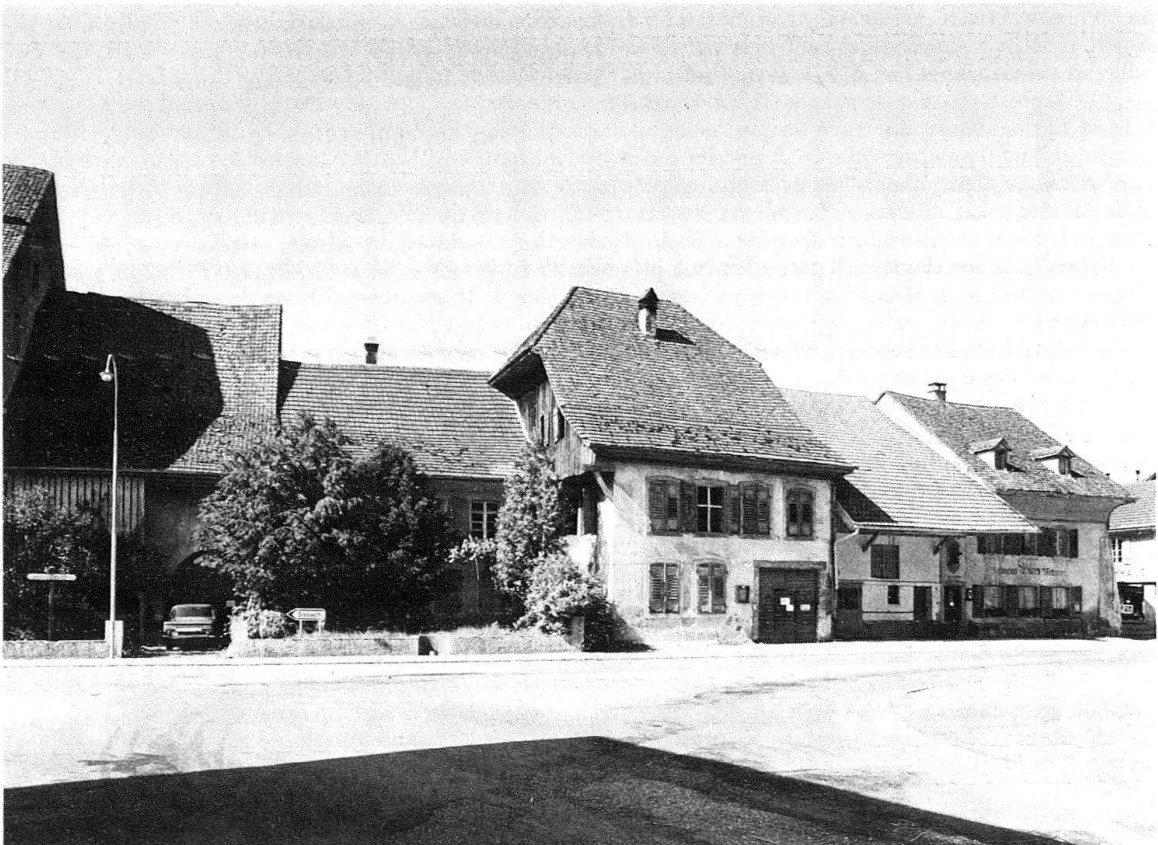
Von rechts nach links: Restaurant Bären mit Scheune. – Ormalingenstrasse 3 mit hohem Krüppelwalmdach, Ende 18. Jahrhundert. – Ormalingenstrasse 1 mit niederem Wohnteil und höherer Scheune, datiert 1797. Verschwunden wären eigentlich 3 Baukuben von der Scheune links bis zum hohen Krüppelwalmdach rechts. Dadurch wäre eine kaum wieder zu schliessende Lücke im Dorfbild entstanden
