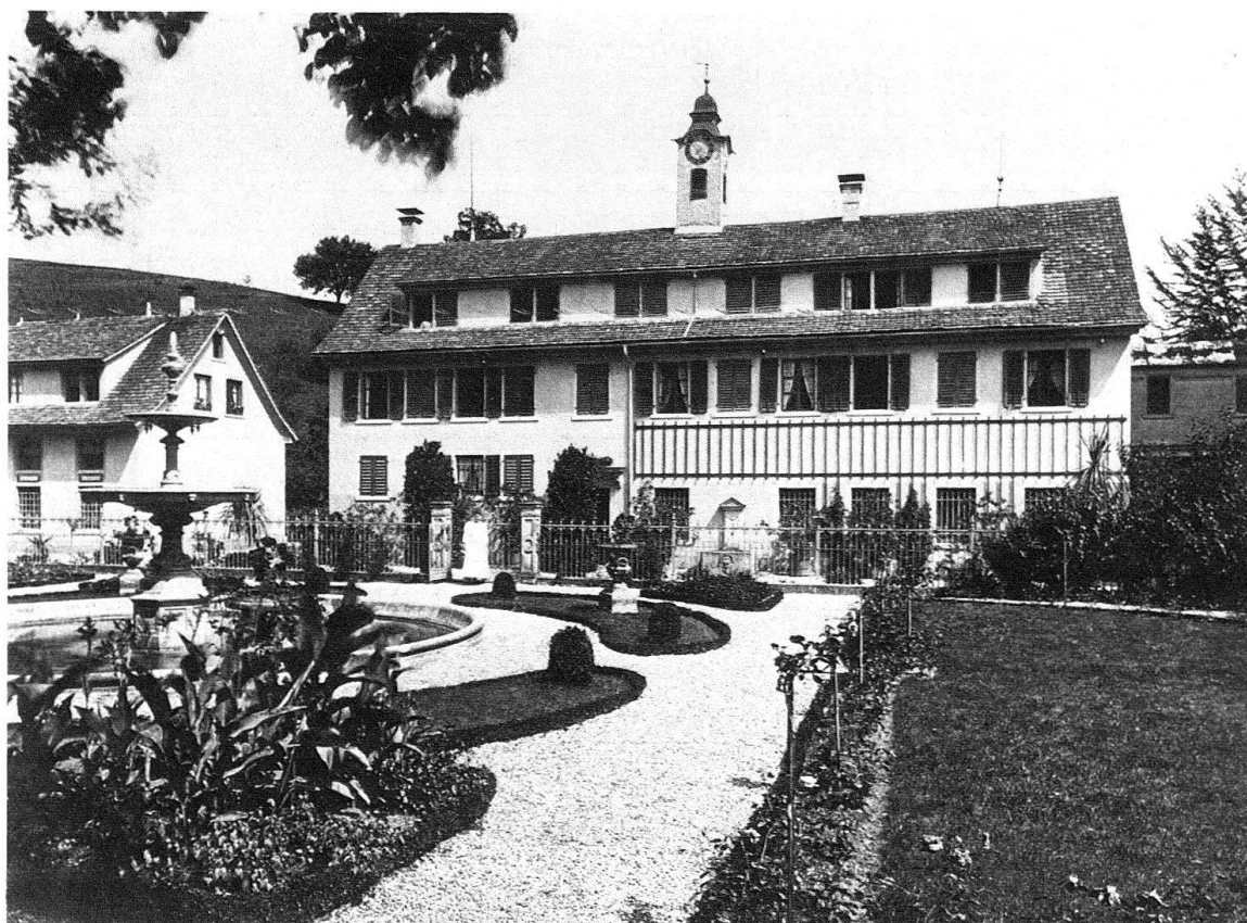
Bäretswil-Neuthal. Wohnhaus von 1835 mit Parkanlage. Bestand um 1900
