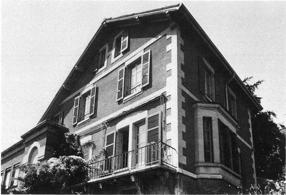
Lausanne. «La Vedette» (1874–1876). Etat en août 1974, une année avant la démolition, (Photo Georg Germann)
