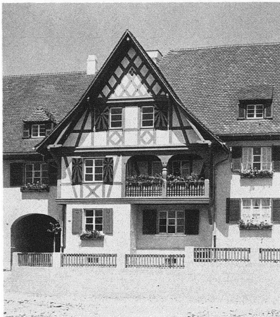
Arbeiterkolonie der Eisen- und Stahlwerke vorm. Georg Fischer, Schaffhausen, 1906–1911. Fachwerkgiebel aus der S-Front
