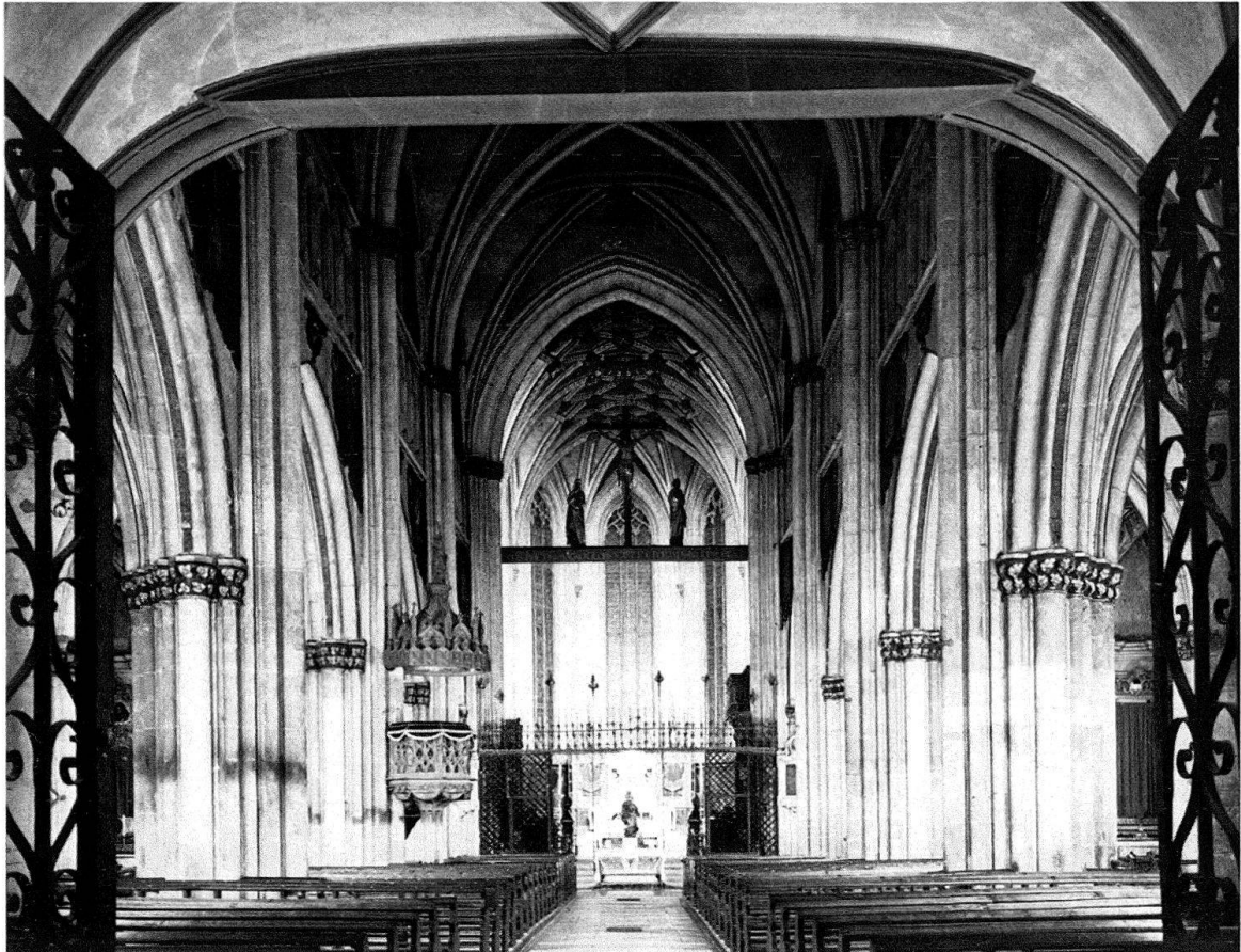
Fribourg, Kathedrale St-Nicolas. Chorseitig an den Säulen Opalglaszylinder (Glühlicht), Scheinwerfer 300 Watt im Triforium, zusätzliche Spotleuchten für Festbeleuchtung. A. Knoepfli: «... den hohen Raum in der Höhe und nach der Tiefe hin verdämmern zu lassen.» – Experten: Prof. Dr. Linus Birchler †, Feldmeilen. Prof. Dr. Alfred A. Schmid, Fribourg
