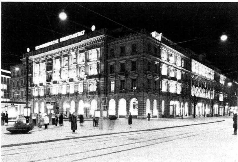
Abb. 9. Zürich, Paradeplatz 8, Schweizerische Kreditanstalt. Anstrahlung aus dem Innern der Balkonischen beschränkt auf die Hauptachsen der Fassade. Gutes Beispiel für die Steigerung der Architektur durch Licht
