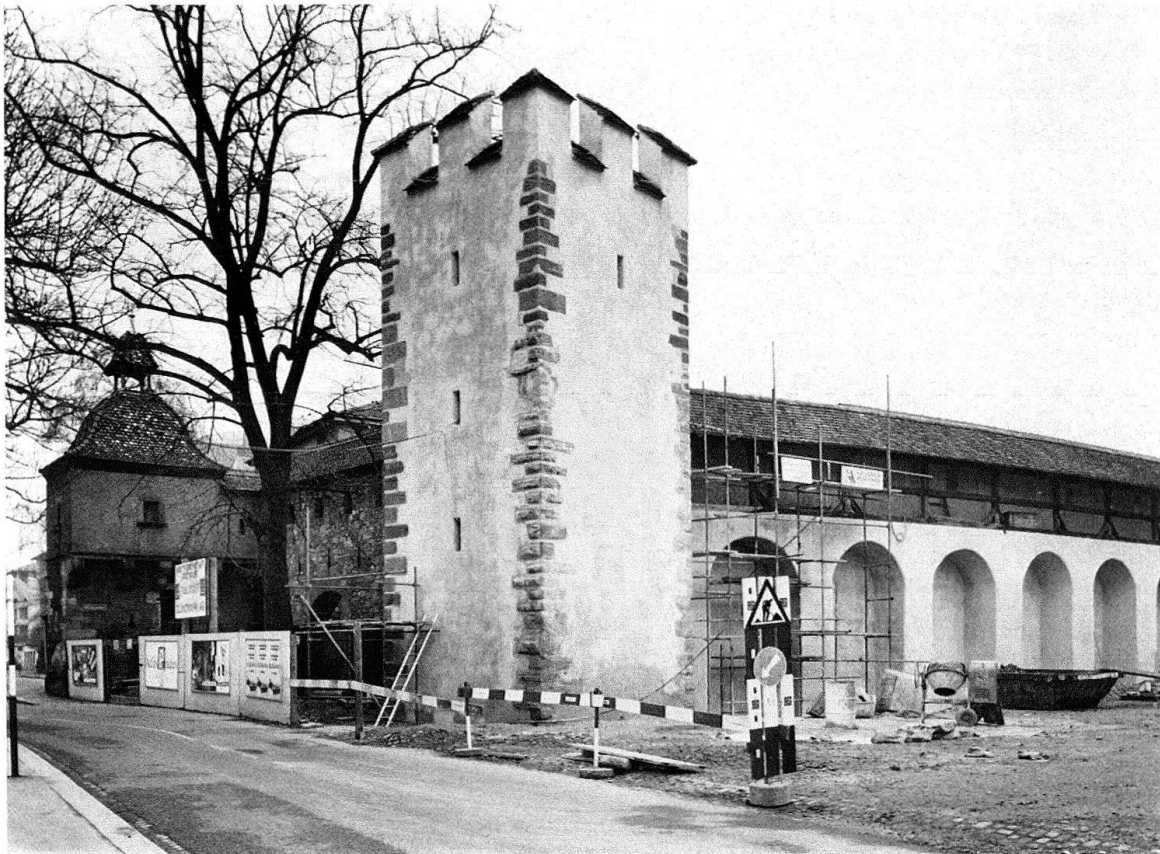
Abb. 3. Basel. Eckturm, Innenseite. Rekonstruktion; Vorderwand mit bossierten Eckquadern original
