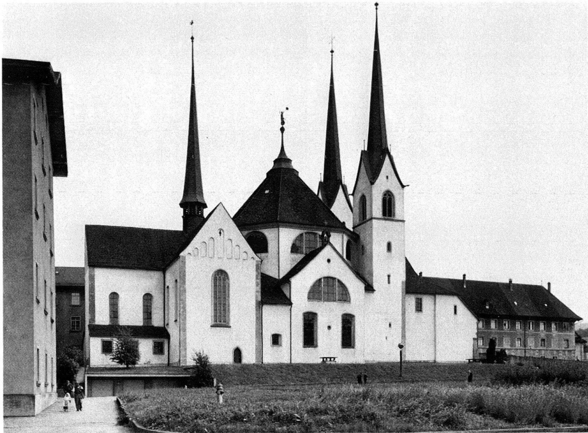
Muri. Ehemaliges Benediktinerkloster. Kirche von Norden, 11. Jh. Der Oberbau des Nordwestturms und die frontseitigen Spitzhelme von 1558, das Oktogon mit der Seitenkapelle von 1695 ff.
