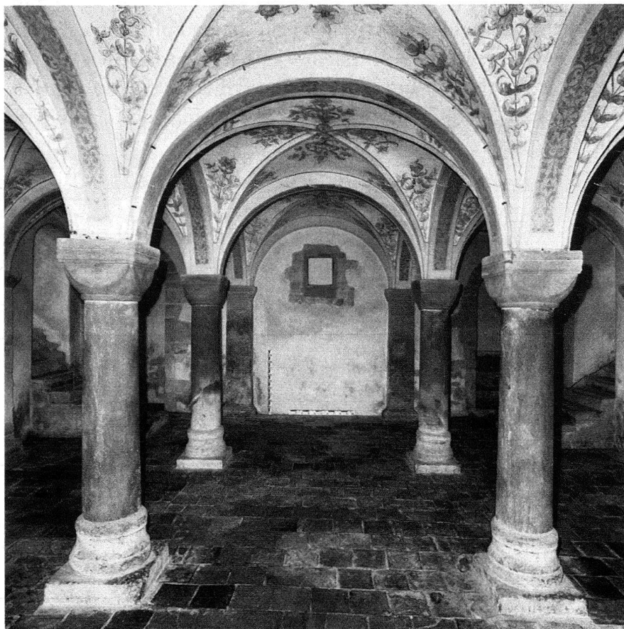
Muri. Ehemaliges Benediktinerkloster. Krypta gegen Westen, zweites Drittel des 11. Jh.
