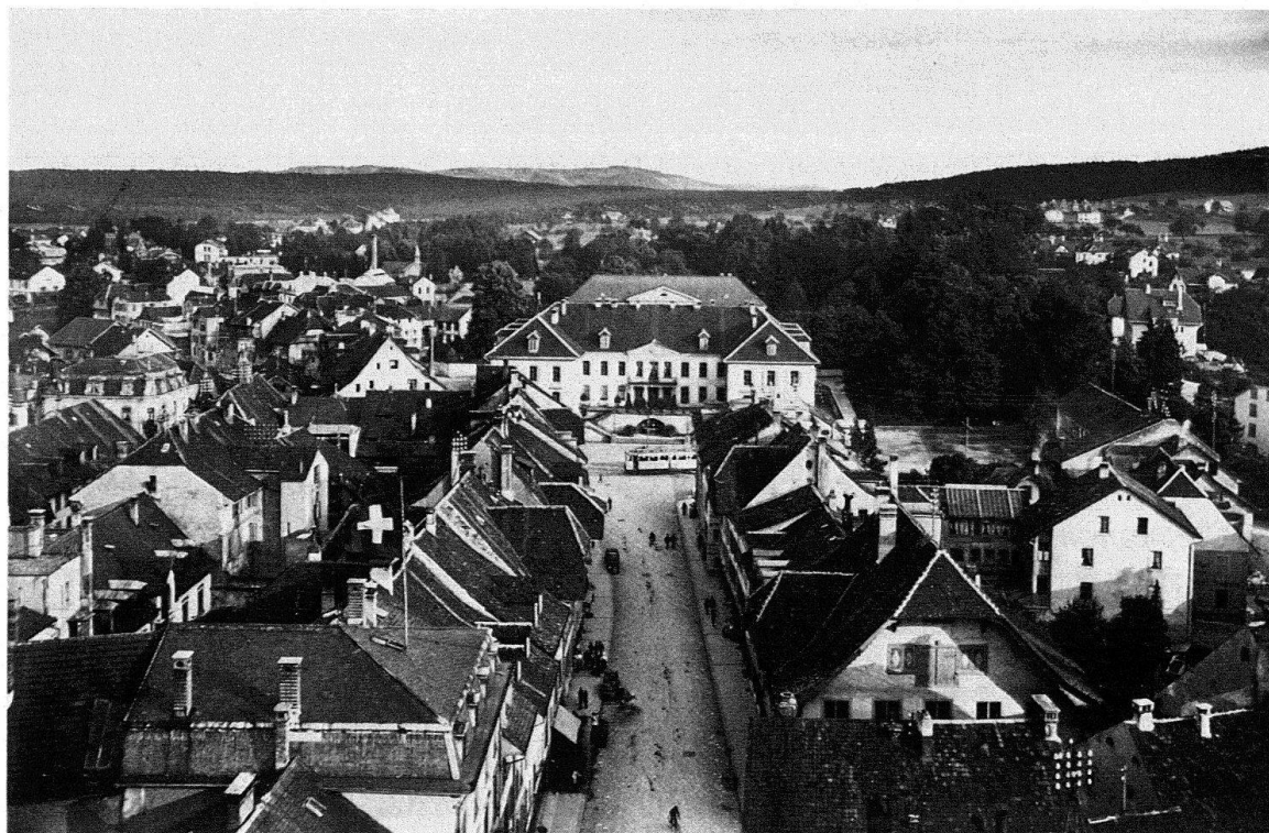
Abb. 2. Aarau. Regierungs- und Grossratsgebäude vom Oberen Tor aus, die Vordere Vorstadt im Vordergrund
