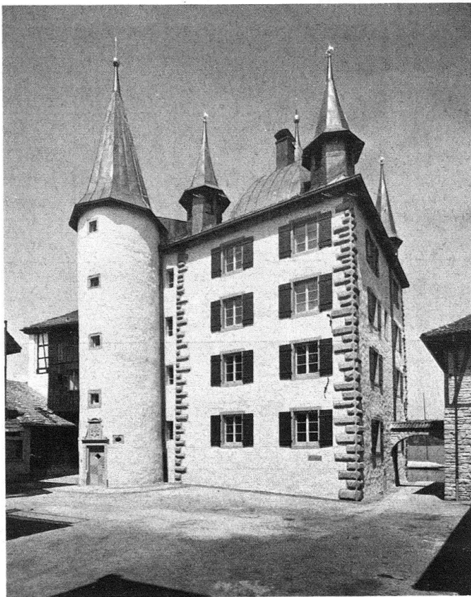
Steckborn. Turmhof nach der Restaurierung
