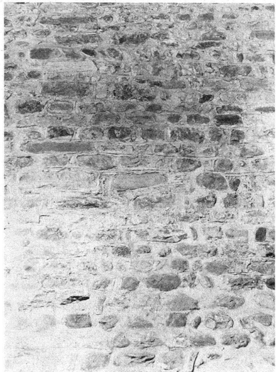
Wagenhausen. Propsteikirche, Detail des Mauer- werkes im heutigen Zustand
