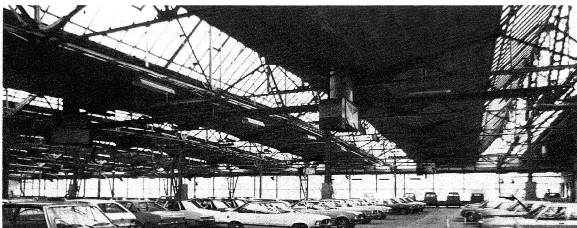
Abb. 5. Biel. Montagehalle der General Motors Swiss, erbaut 1935–1937 nach Plänen des Stadtbauamtes, Experte der GM: Rudolf Steiger. Aufnahme vor den Umbauten von 1976
