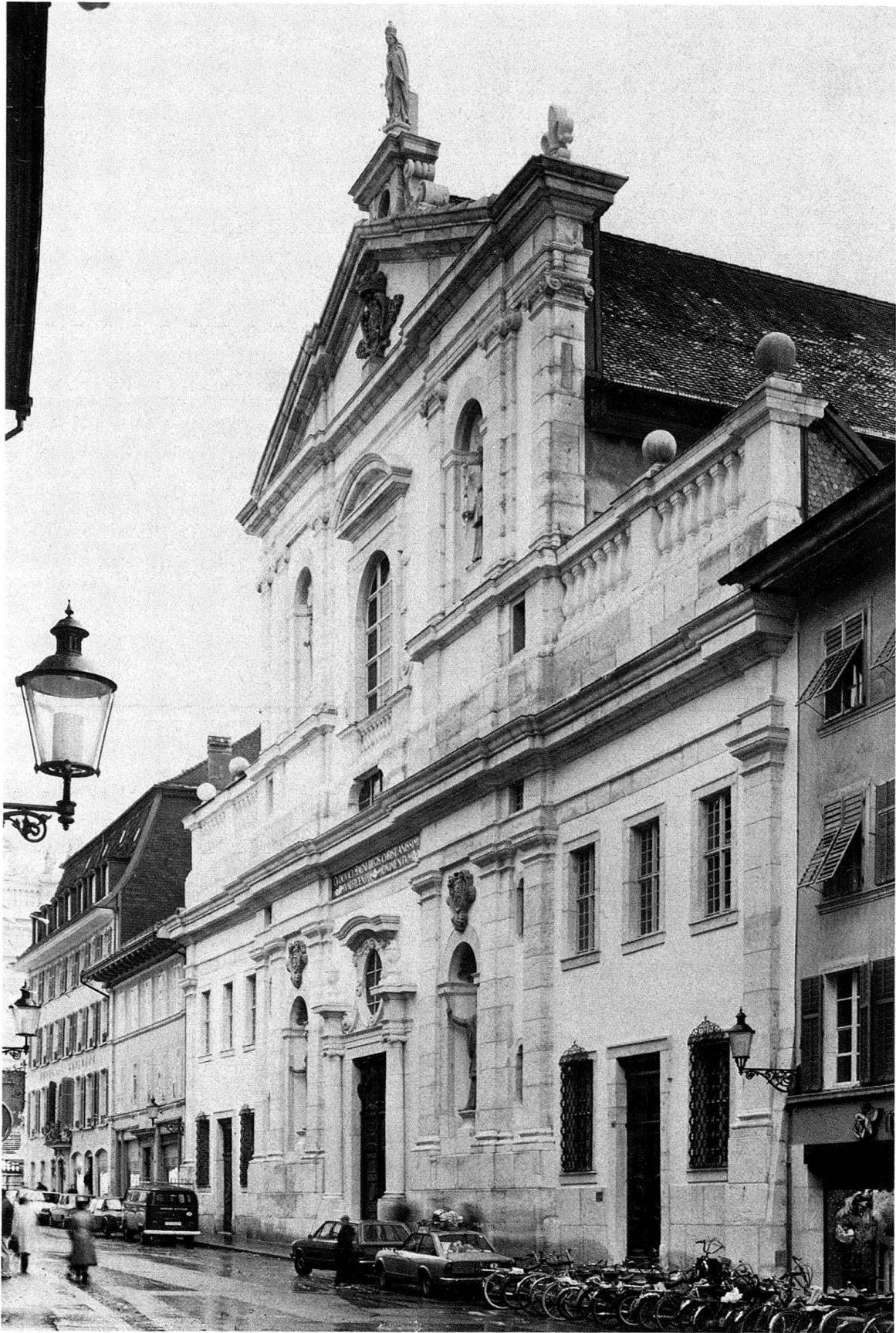
Die Fassade der Solothurner Jesuitenkirche nach der Restaurierung von 1980
