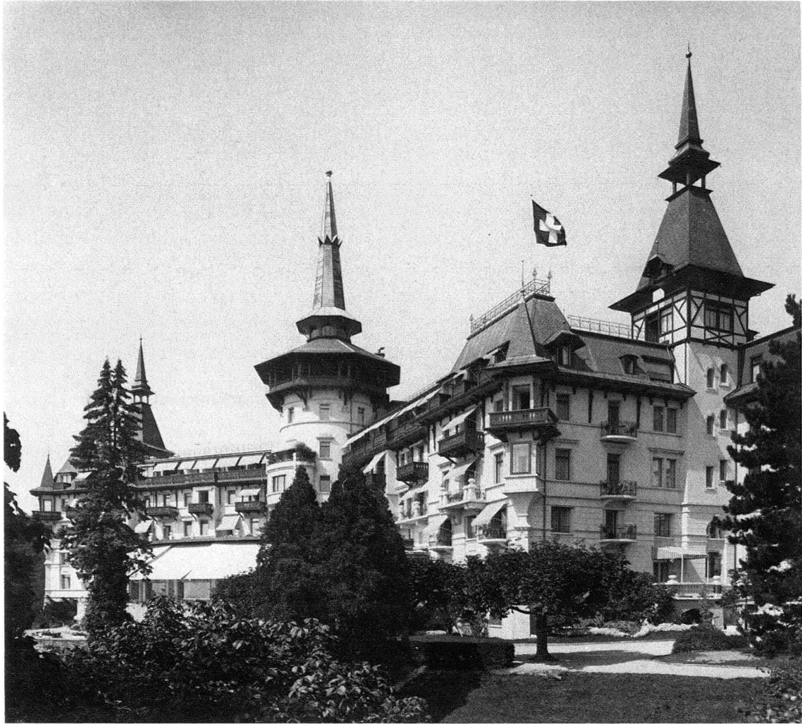
Zürich. Kurhausstrasse 45, «Grand Hotel Dolder». Die renovierten und teilweise ergänzten Fassaden und Dachflächen
