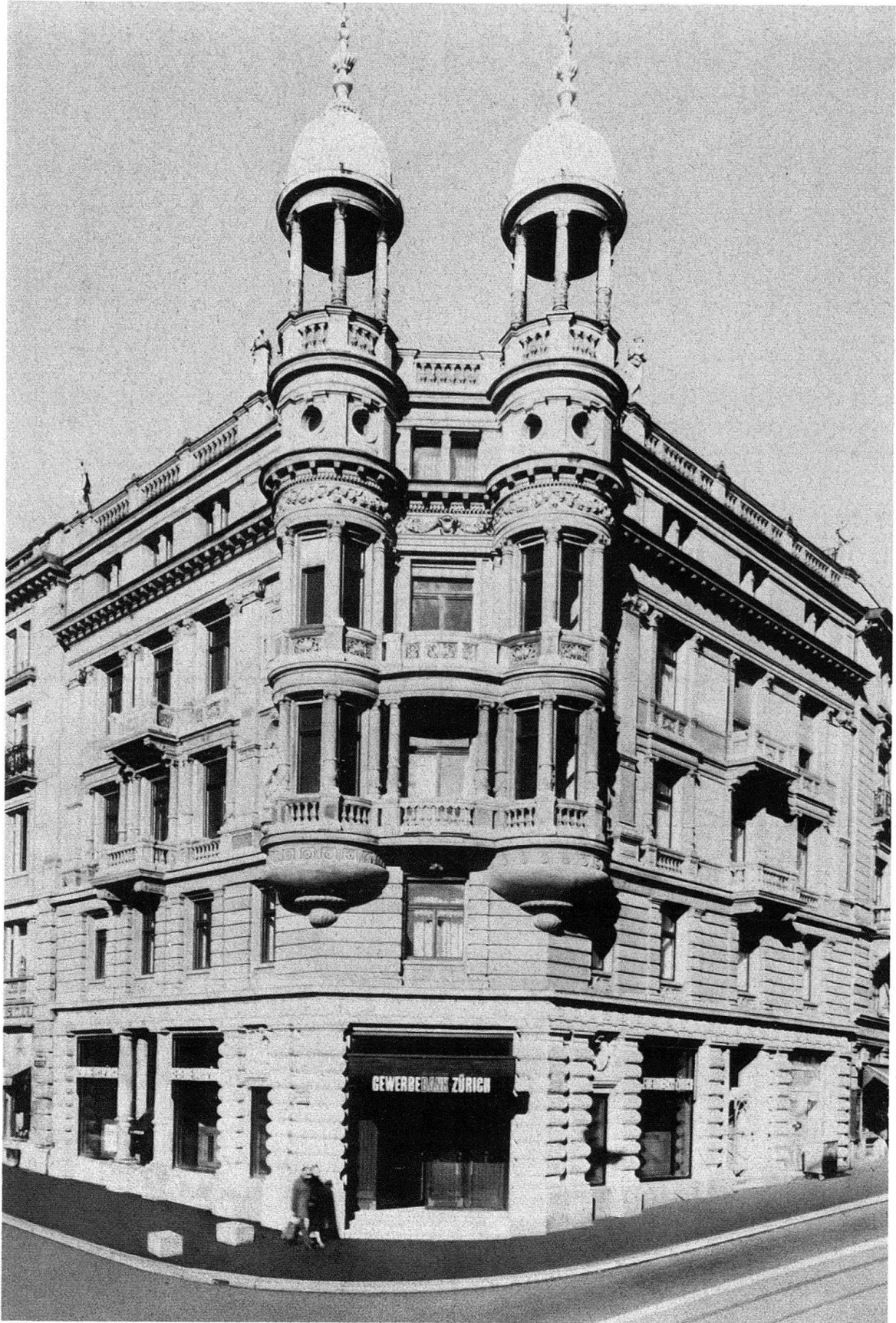
Zürich. Rämistrasse 23, «Gewerbebank». Fassade nach der Renovation
