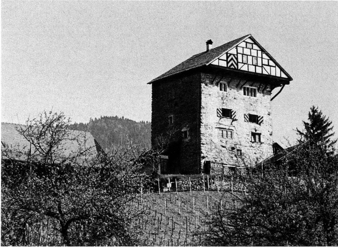
«Neu Altstätten» ob Lüchingen im Rheintal, ein trutziger Wohnturm
