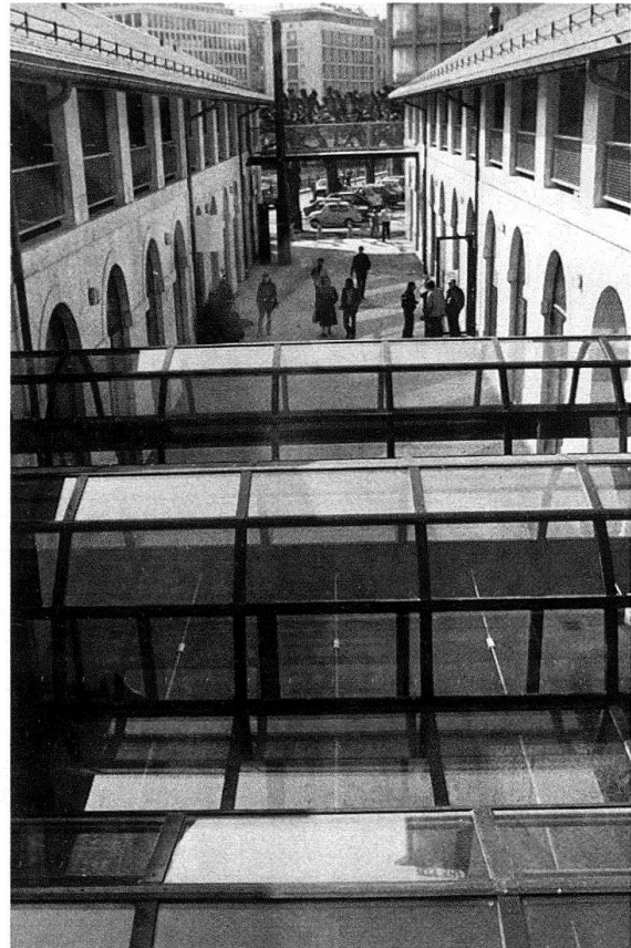
Genève, Halles de l'Île; vue de la rotonde sur l'allée centrale et les deux ailes
