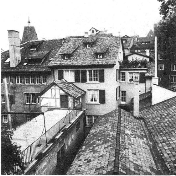
Abb. 12. Gesamtübersicht über Steinbockgasse 7 mit Söller und Verbindungsgang. Deutlich sichtbar die zurückgestutzte Lukarne mit dem Dachterrassli Abb. 13. Innenraum des Söllers mit dem offenen Dachstuhl, den Wandmalereien und der Türe zum ehemaligen Festsaal
