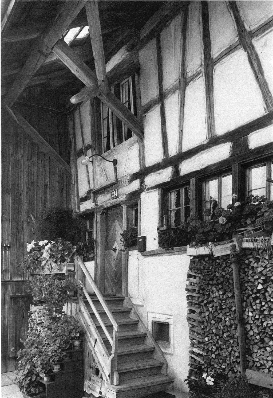
Abb. 7. Tobelhof. Aktueller Zustand der noch bäuerlich bewirtschafteten Haushälfte. Die Verdrängung des Bäuerlichen brächte einen grossen Verlust
