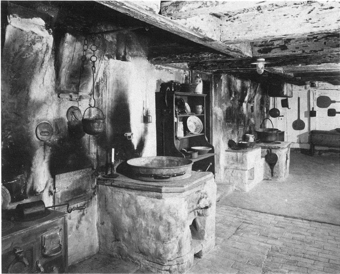
Abb. 13. Dachslernstrasse 20. Küche (heute Teil des Ortsmuseums) mit Originalherden und Gestellen. Man beachte die Feuerplatte zwischen den beiden Sechtöfen, auf die später ein Herdkasten aufgemauert wurde
