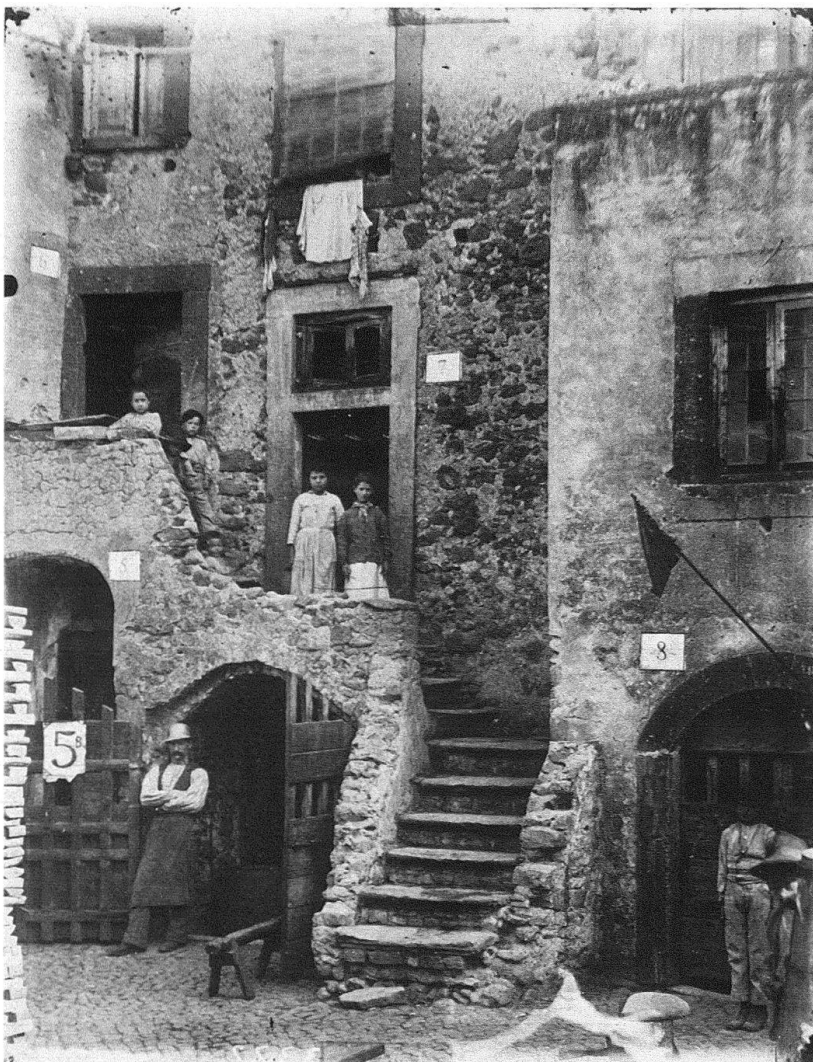
Abb. 5. Genazzano-Via Sopportici (anno 1872) 5 : Eine Reihe von Turmhäusern mit vorgebauter Treppe. Da kein Platz mehr vorhanden war, bei jedem Haus eine Freitreppe vorzubilden, schlossen sich die Nachbarn zusammen. Bei Haus 8 ist die Treppe zu einem Treppenhaus, beziehungsweise Vorraum erweitert, ein Ausnahmefall
