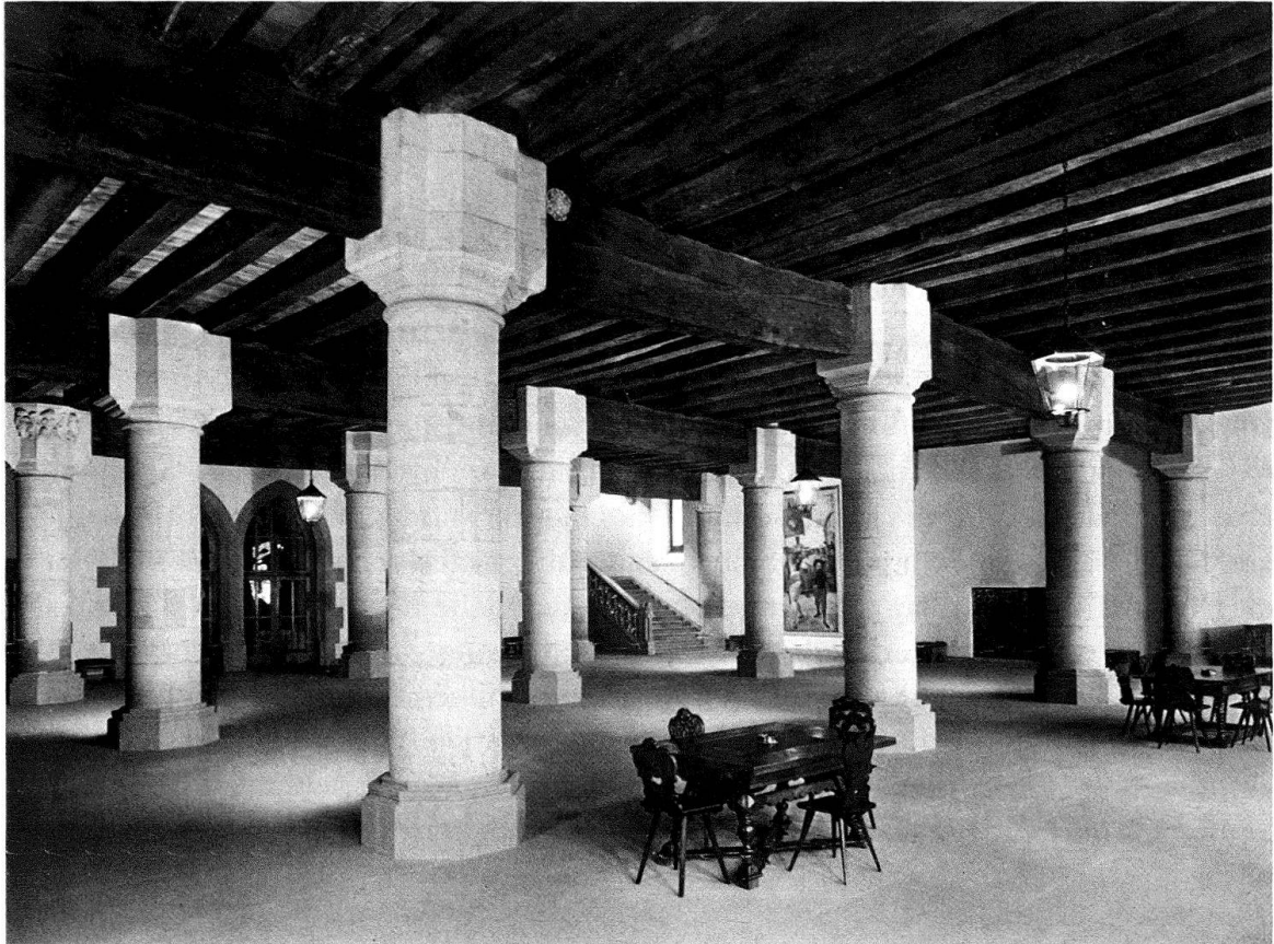
Abb. 7. Rathaus, Erdgeschosshalle. Ehemalige Versammlungshalle der Bürgerschaft. Leicht trapezförmiger Grundriss mit rund 22 m Seitenlänge. Die Balkendecke getragen von drei Unterzügen, die von mächtigen, sandsteinernen Rundpfeilern gestützt werden. In der Nordwand eine Fensterreihe mit stichbogigen Sitznischen
