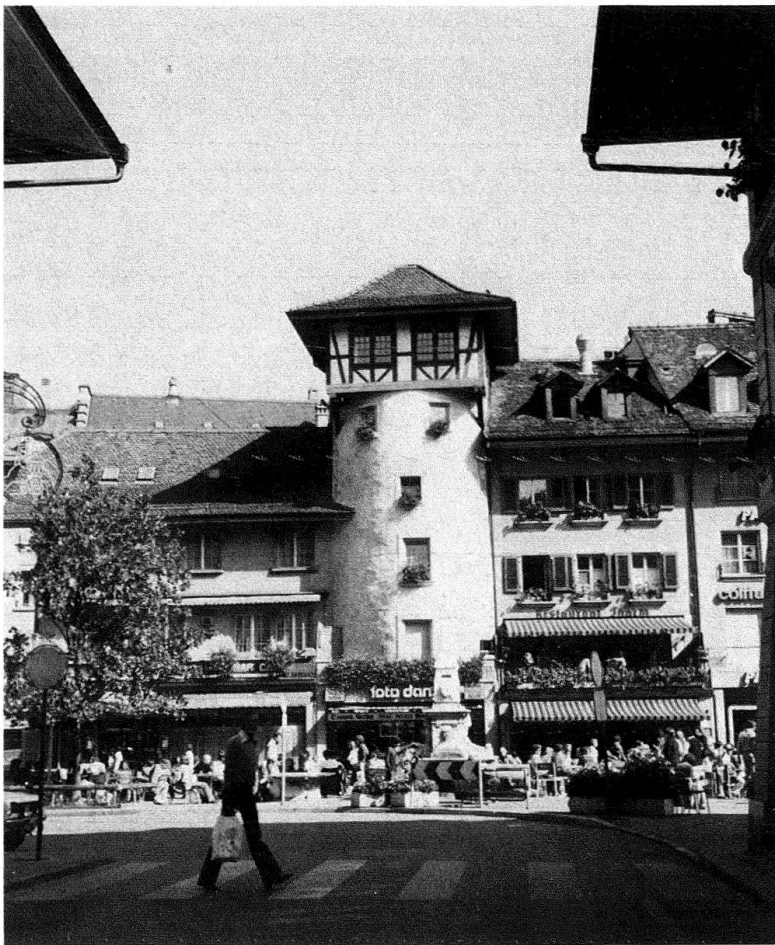
Abb. 5. Holländerturm am Waisenhausplatz. Halbrunder Wehrturm im Verlauf der äusseren Ringmauer des dritten Westgürtels von 1256. Aussen verputzte, massive Turmschale, die Flanken in Sichtquaderwerk. Der Zinnenkranz ist seit dem Umbau zum Wohnhaus im 16. Jahrhundert durch Fenster markiert. Die in Riegkonstruktion aufgesetzte Turmstube des 17. Jahrhunderts diente den ehemaligen Offizieren in holländischen Diensten als Versammlungs- und Rauchsalon, daher der Name
