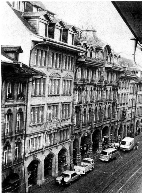
Abb. 5. Kaiser-Häuser an der Marktgasse 37–41 nach der Gesamterneuerung: Umbau statt Abbruch
