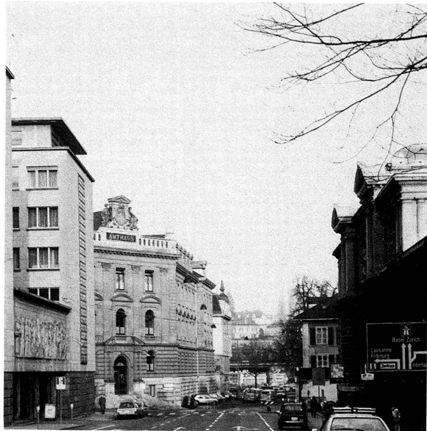
Abb. 7. Amthaus, Situation im Strassenraum. Rechts Kunstmuseum, links Telegrafendirektion
