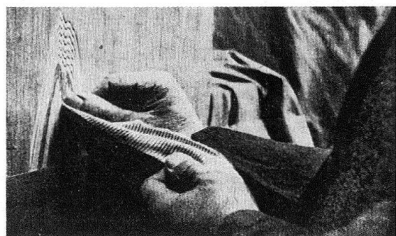
Abb. 7. Eichenholzmalerei in Öllasur: Kammzug mit eingekerbter Gummiplatte, Ausziehen des Kernes mit dem Lappen
