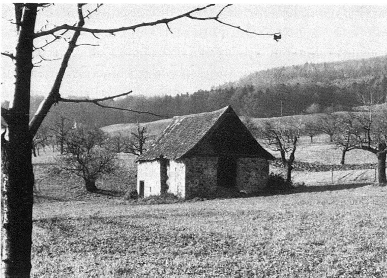
Abb. 3. Futterscheune in Ormalingen, Gmeinimatt, baulich gefährdetes, aber noch als Scheune benütztes Objekt
