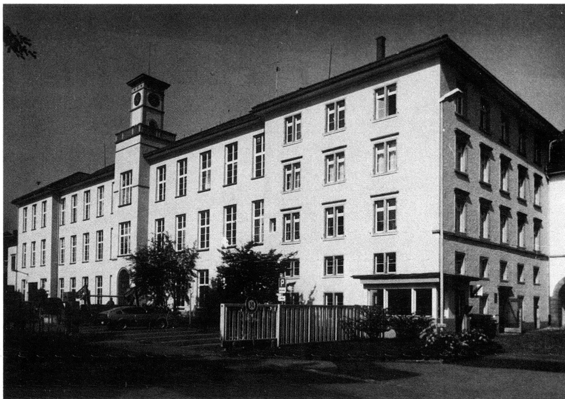
Abb. 2. Uster. Seidenspinnerei Bindschädler, 1852 erbaut, um 1900 Galerieausbau für die Automobilfabrik Turicum, nach der Liquidation der Firma Turicum Rückverwandlung in einen Etagenbau für die Apparate- und Maschinenfabrik Zellweger. Zustand nach der Aussenrenovation 1981/82
