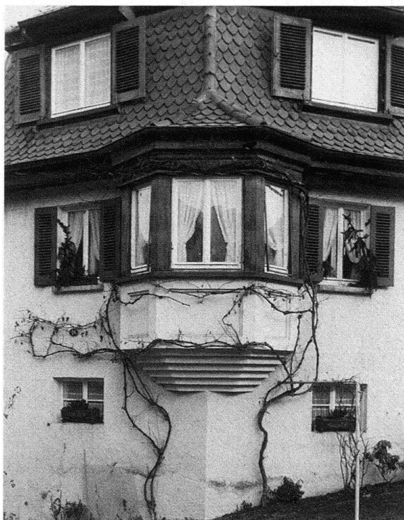
Abb. 5. St. Gallen, Schorensiedlung. Erker am Eckhaus Fichte-/Sonnenbergstrasse
