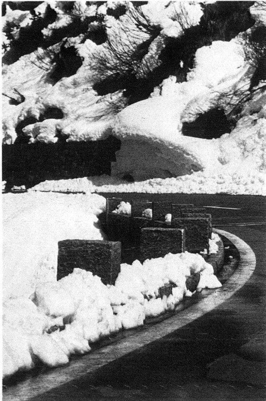
Abb. 5. Sustenstrasse. Wehrsteine und Radabweisstein
