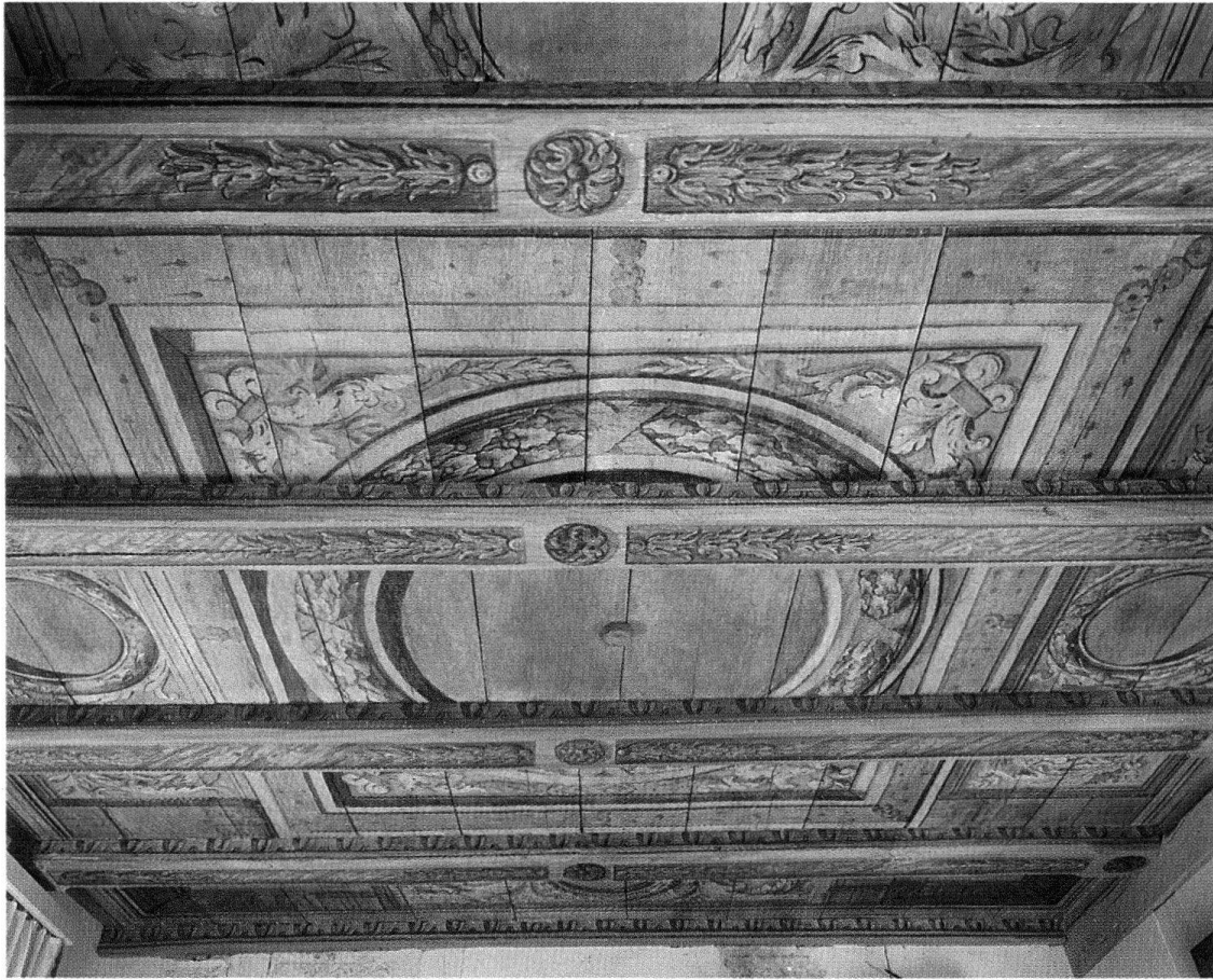
Abb. 7. Solothurn. Türmlihaus. Bemalte Holzdecke im östlichen Zimmer des Erdgeschosses, wohl um 1680. Nach der Restaurierung
