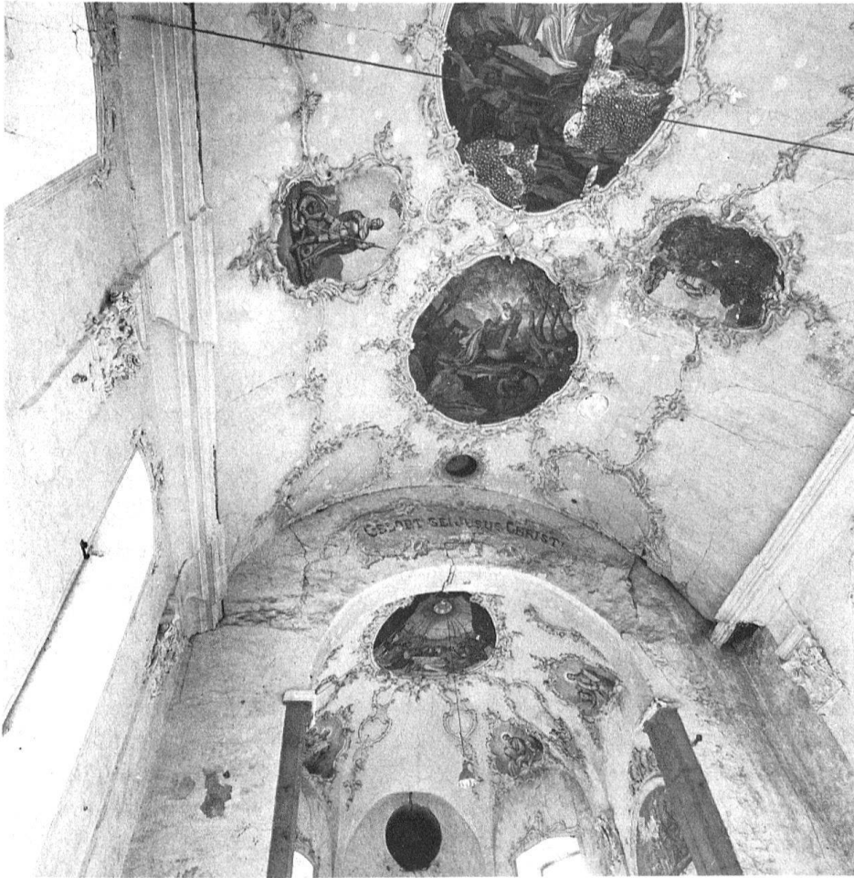
6 Flüelen, Alte Kirche, vor der Innenrestaurierung, Blick in Chor- und Kirchenschiffgewölbe.
