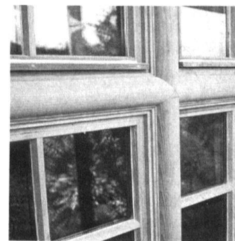
4 Mettmenstetten, Wohnhaus im «Buchstock». Fensterersatz in Isolierverglasung als Kopie des Originalfensters.
