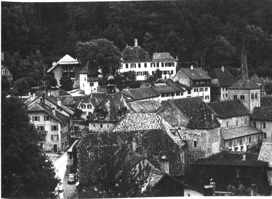
1 Romainmôtier. Reconstruction d'un bâtiment d'habitation sur l'emplacement de l'an- cien rural de la maison de Lerber. Vue générale du site.
