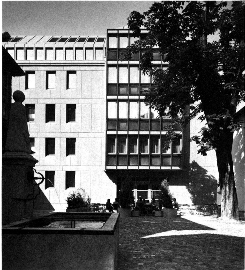
10 Zürich. Bank Julius Bär, Neubau II 1980–1983, Fassadendetail. Kontrast zwischen gestockten Betonflächen und dem reichen Spiel der einbrennlackierten Metallprofile der Erker.
