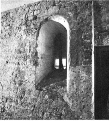
8 St. Petersinsel, ehem. Cluniazenserpriorat. Dormitoriumsfenster im Obergeschoss des Ostflügels.
