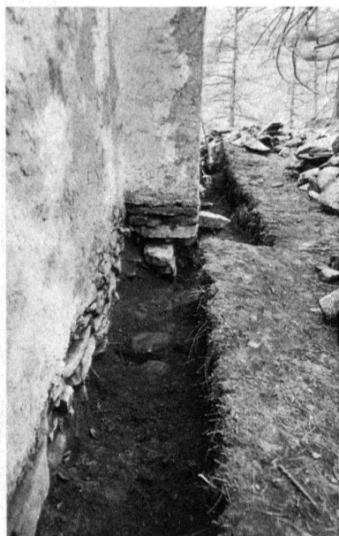
4 Torre – San Salvatore. L'angolo nord-est della navata appoggiato sull'angolo opposto di un edificio preesistente.
