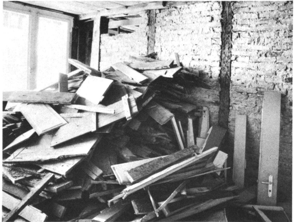
3 Herausgerissene Täfer in einem Wohnraum an der Rathausgasse.
