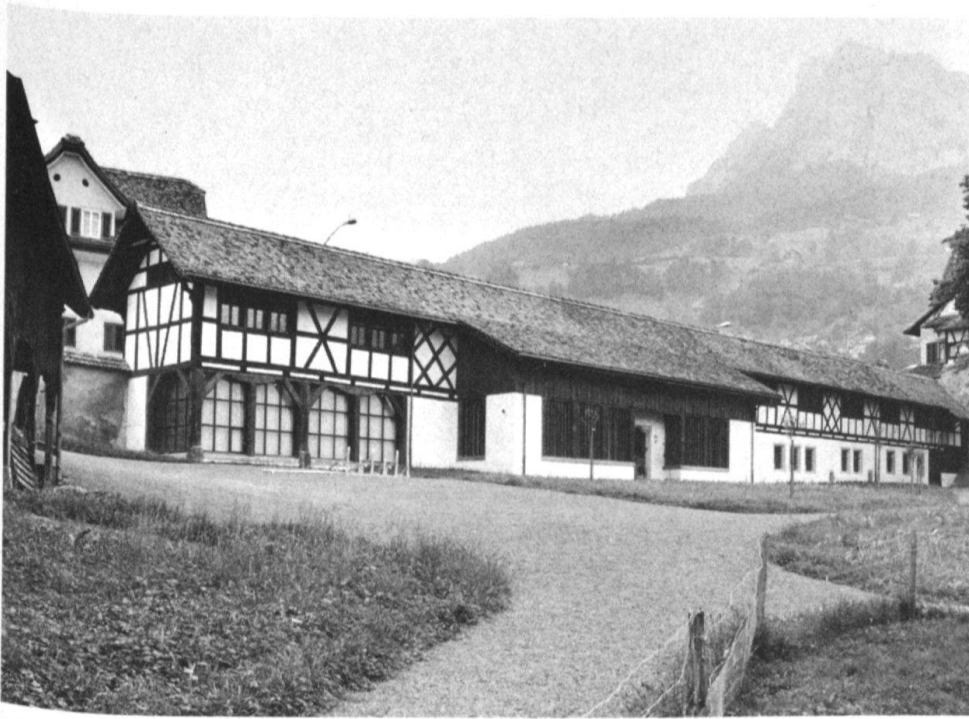
1 Schwyz, Ital Reding-Haus, Ansicht von Südwesten.
