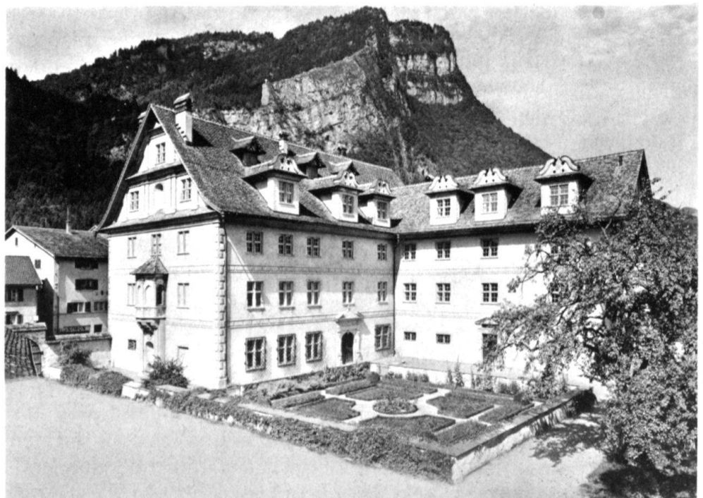
1 Der Freulerpalast nach der Renovation von 1937–1942. Der einheitliche Farbton verlieh den Fassaden nur wenig Gliederung. Quader, Lisenen, Portale und Fenstergehänge hoben sich nur durch Licht und Schatten etwas von den Mauerflächen ab.
