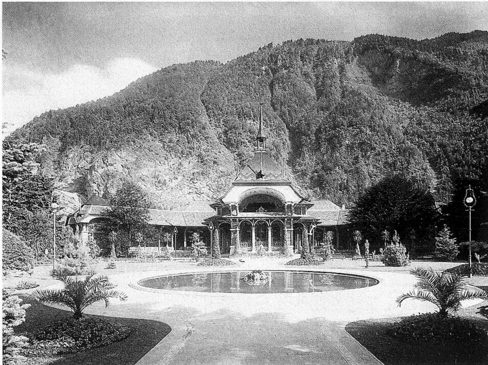
6b Interlaken, Kursaal. Die Konzerthalle vor deren Erweiterung und Verglasung nach dem Zweiten Weltkrieg.
