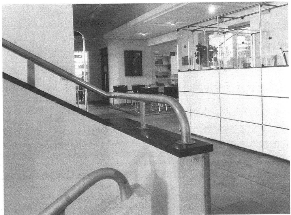
3 Berner Schulwarte: Eingangsbereich mit Zugang zum neuen Katalogsaal; im Vordergrund Treppenaufgang aus der Bauzeit mit aufgesetztem, glanzverchromtem Handlauf auf Abdeckplatte sowie neuer Treppenabgang mit mattem Handlauf auf verputzter Mauerkrone.
