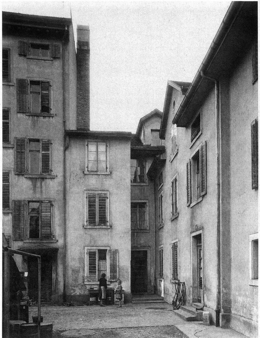
7 Innere Verdichtung durch Schliessung der Baulücken: aneinandergereihte Haustypen in Zürich-Aussersihl, Sihlhallenstrasse 11 (1893 erbaut, 1966 abgetragen), 13 (1876–1966), 15 (1864–1966), 17 (1867–1966). Photo 1956.
