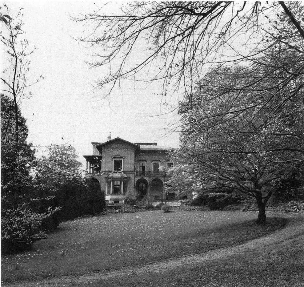
6 Hauptfassade, 1988. Die Bäume haben ihren Höhepunkt erreicht. Von den anspruchsvolleren Sträuchern, Stauden und Kübelpflanzen haben nur wenige die minimale Pflege der letzten Jahre überlebt.
