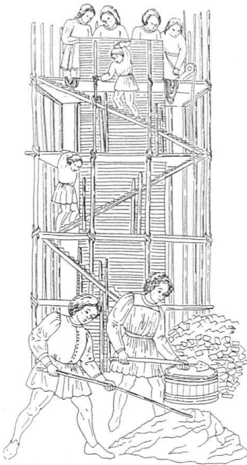
3 Beim Stangengerüst werden die Gerüstbohlen vom Boden her mit Stangen gestützt. Umzeichnung nach der «Bibbia di Borso d'Este»; 1452–1479; Modena, Bibl. Estense, Ms V. G. 11, vol. I, fol. 9r.
