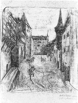
7 Rekonstruktion des Schlosshofes im Stil der Spätgotik, Blick auf den südlichen Kapellentrakt. Zeichnung von Egon Rheinberger, 1902.
