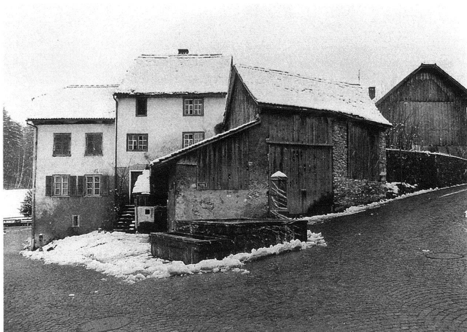
2 Balzers, Iradug 74 und 76, neuere Massivbauten, 1907 und 1841 mit Stallscheune, abbruchgefährdet.
