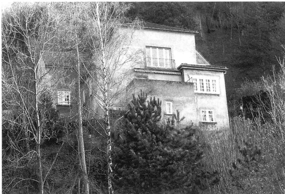
1 Vaduz, Wohnhaus Prof. Ferdinand Nigg, 1926. Architekt: Egon Rheinberger. An dominanter, ursprünglich freier Lage über den Weinbergen von Vaduz errichtet, stellt die Villa ein erstes Baudokument moderner Architektur im Fürstentum dar.
