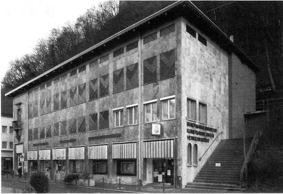
5 Vaduz, «Engländerbau», 1933–34. Architekt: Erwin Hinderer. Das ehemalige Büro- und Geschäftshaus erhielt bei seiner Adaption als Museumsbau profilierte Blechelemente, welche in die Fensteröffnungen gesetzt wurden.
