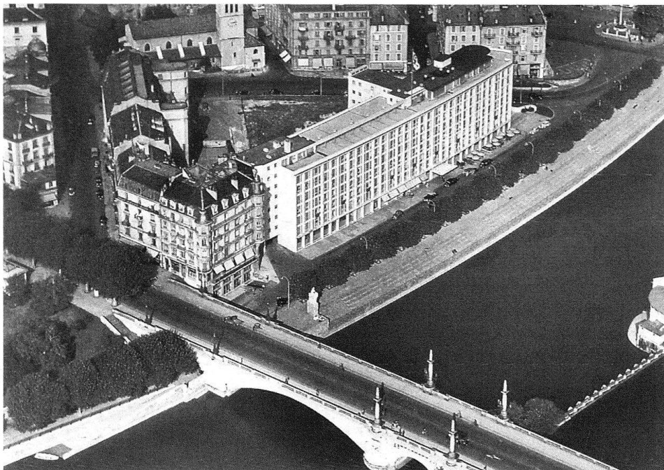
7 Genève, L'Hôtel du Rhône au quai du Seujet, construit par Marc-J. Saugey de 1947 à 1950.
