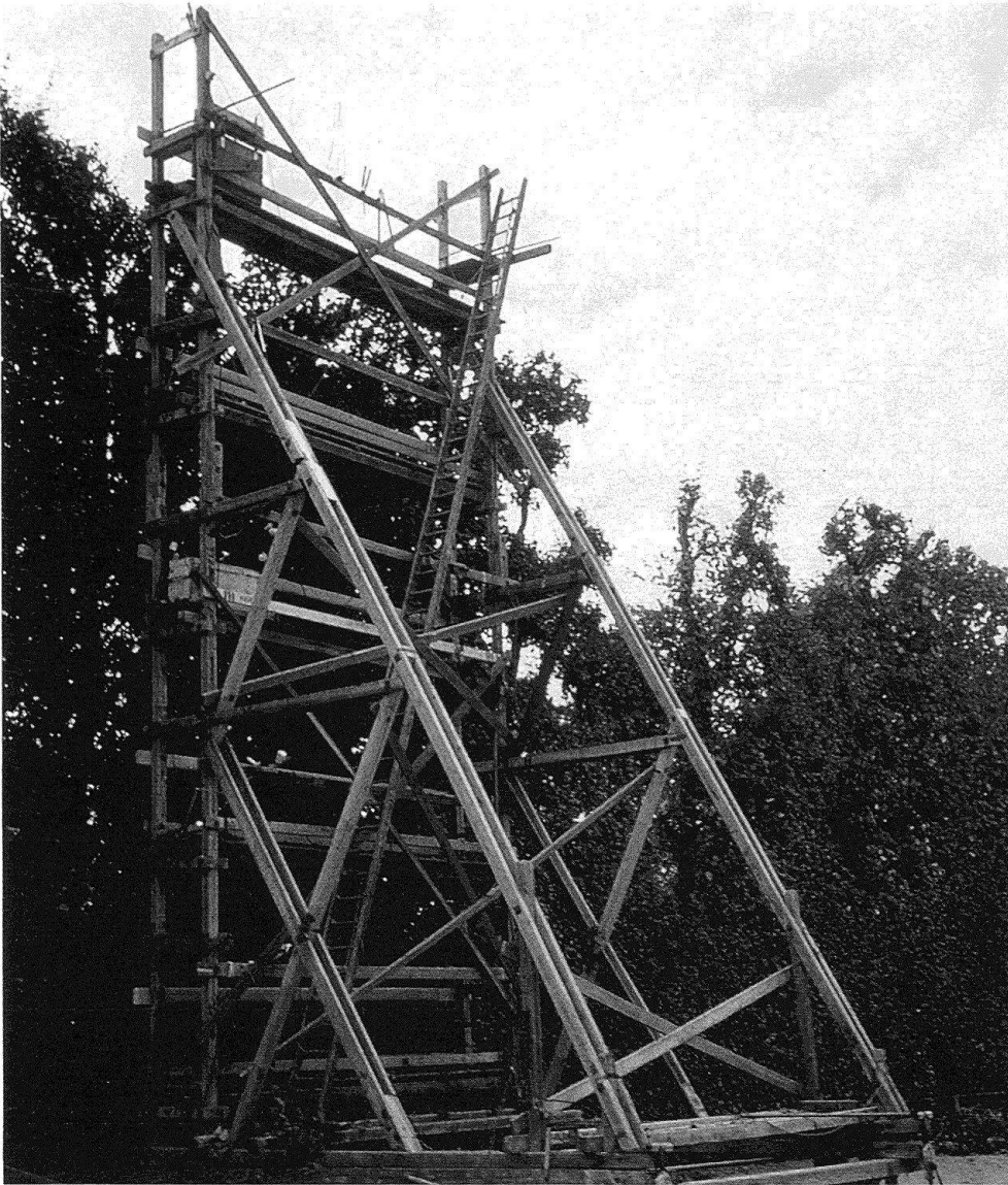
4 Wien, Schönbrunn. Gerüst für den Hecken- schnitt.
