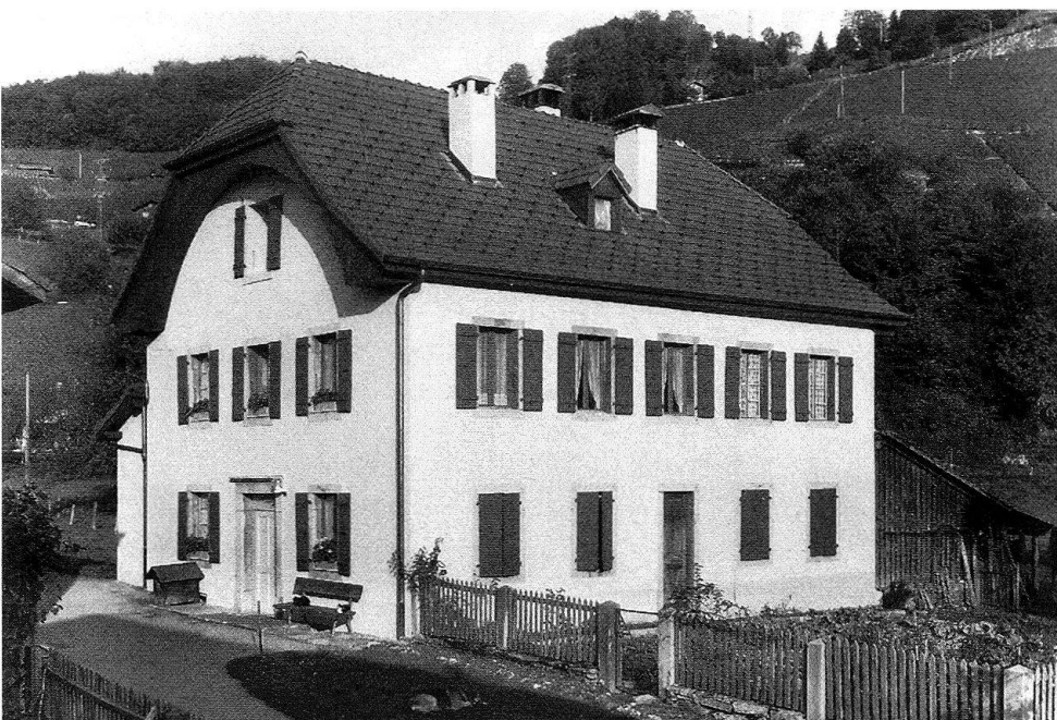
3 Bex, les Dévens. La « maison grise » du naturaliste Emmanuel Thomas, construite vers 1825 d'après les plans de Jean de Charpentier, photographiée en 1992.
