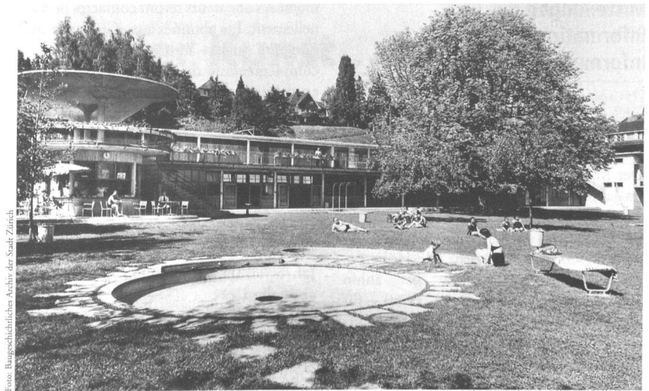
Strandbad Wollishofen, erbaut 1939 vom Stadtbaumeister Hermann Herter.
