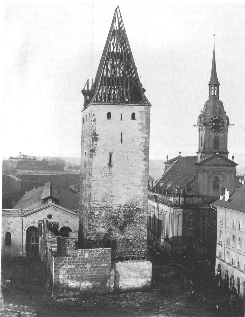
6 Bern, Christoffelturm zwischen Bahnhof und Heiliggeistkirche. Zustand kurz nach Abbruchbeginn im Januar 1865.
