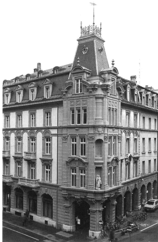
6 Die Fassaden des 1904 von Otto Lütstorferbauten Simphon-Hauses an der Ecke Aarberggasse/Genfergasse wurden jahrzehntelang vernachlässigt. Mitte der siebziger Jahre wurden die Fassaden durch Beseitigung der Dachzier und der Bauplastik verstümmelt. Die 1990-93 durchgeführte Fassadenrenovation hat dem prominenten Eckgebäude seinen Charakter wiedergegeben.
